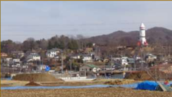
自田地区新小学校建設現場（令和3年1月5日撮影）
